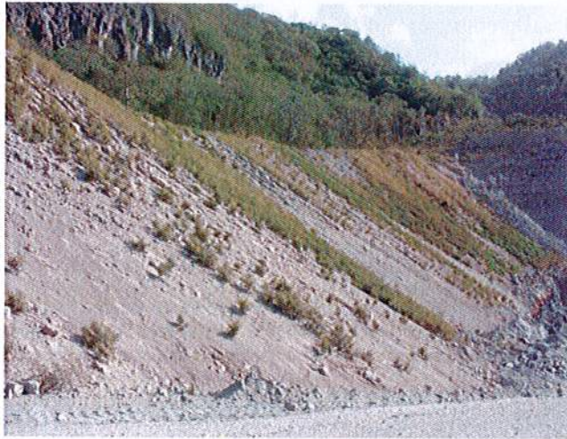
Figure 41 : Illustration de la mise en place d'un talus sur les derniers gradins pour améliorer l'intégration paysagère (2002)
