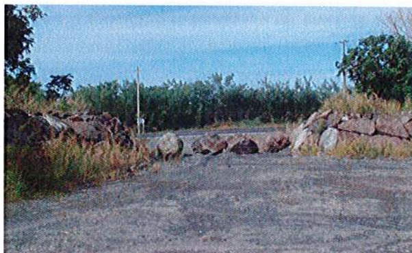
Figure 45 : exemple d'enrochements empêchant l'accès à un site
