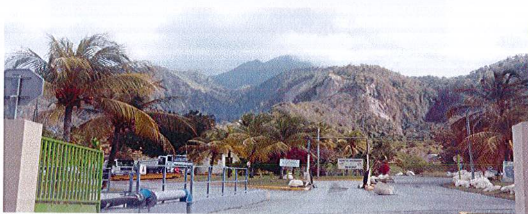
Figure 19 : Vue depuis la RD10 au niveau de l'entrée du site de traitement (RD10)
